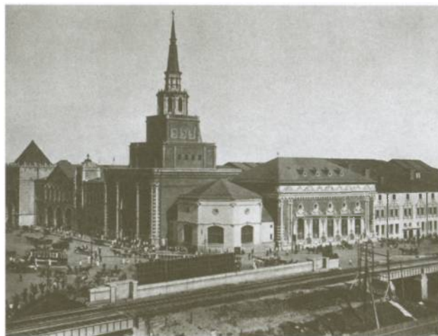
Казанский вокзал в Москве. Общий вид. Архитектор А. В. Шусев. Фотогравюра. 1928 г.
